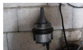
Poste local de sectorisation
